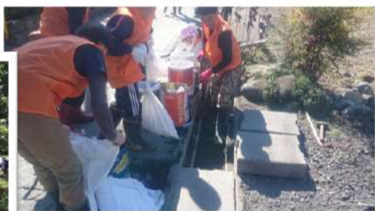
次の大雨であふれる事の無い用に側溝の清掃
